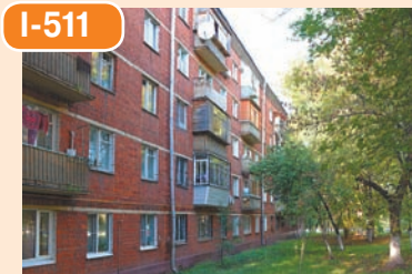
Из кирпича (иногда не 5, а 3 этажа), балконы вдоль дома (на 1-м этаже нет), плоская кровля.
