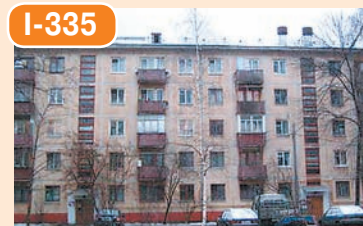
Дома в 5 этажей из крупных панелей, лестничные окна из 4 горизонтальных створок, четырёхскатная кровля.
