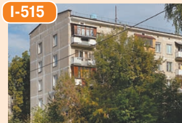
«Панелька» в 5 этажей, балконы вдоль дома (на 1-м этаже нет), кровля плоская или с двускатным уклоном.
