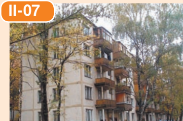
Панельная пятиэтажка, балконы вдоль дома (на 1-м этаже нет), узкий торец, кровля с двускатным уклоном.
