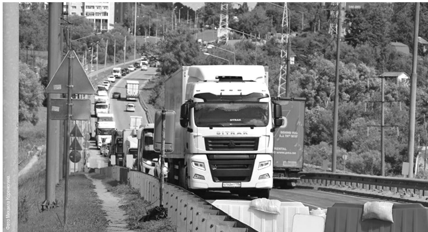
Пробка по направлению из города на мостовом сооружении Калужского шоссе.
