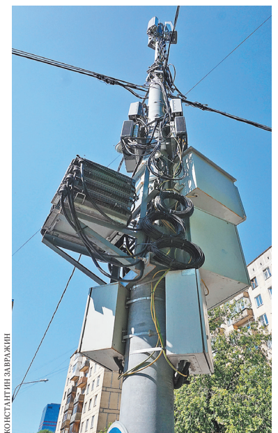
Такое сооружение — это и фонарный столб, и вышка сотовой связи.
