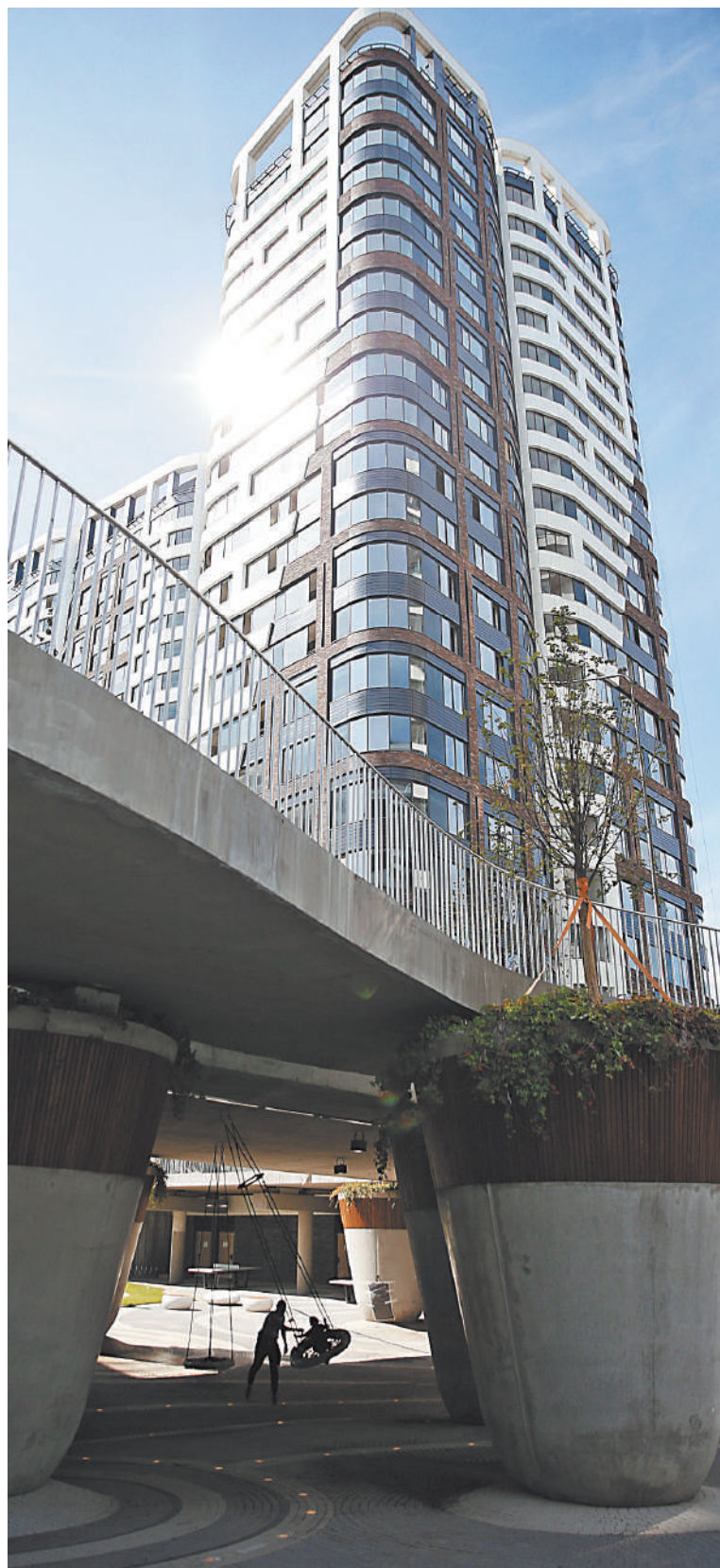
С фигурных опор моста в «Зеленой реке» свисает виноград, а подвесные качели полюбили местные жители. Под мостом даже будут давать концерты.
