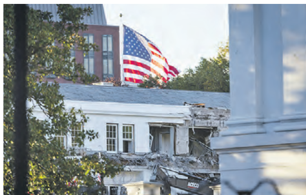
20 октября. В Вашингтоне начался снос части восточного крыла Белого дома перед строительством нового Бального зала
